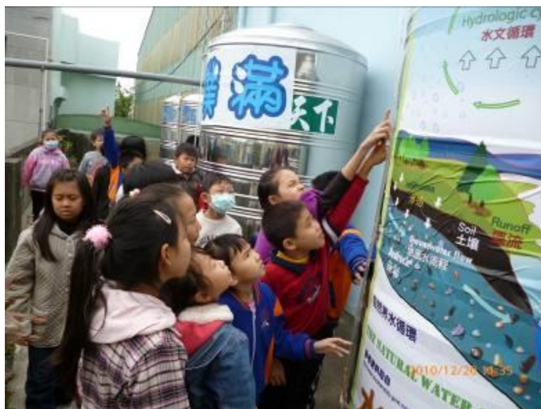
學校裝設雨水回收設施，可儲存約 28 噸雨水
